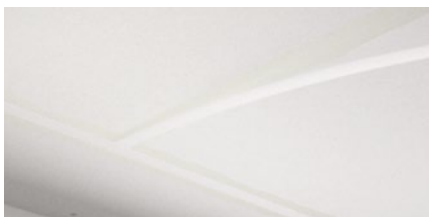
2. Монтаж ленты на стыки до высыхания шпатлевки.
