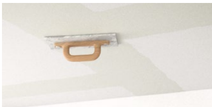
4. Ручная шлифовка стыков, при необходимости.
