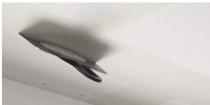
5. После полного высыхания первого слоя Powder Filler, наносят шпатлевку Filler для финишного заполнения стыков (используют шпатель шириной 240 мм).
