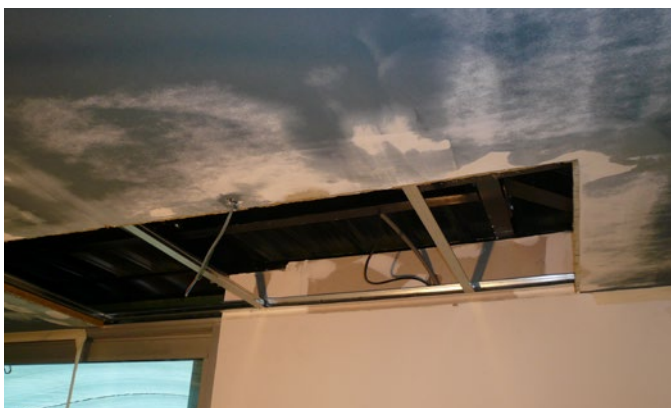
1. Удаление поврежденных панелей и шлифовка участка.
