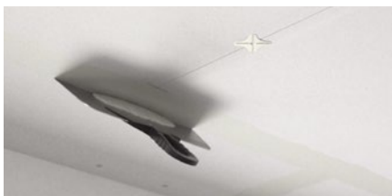
1. Нанесение тонкого слоя шпатлевки Powder Filler на стыки и скобы (используя шпатель шириной 150 мм).
