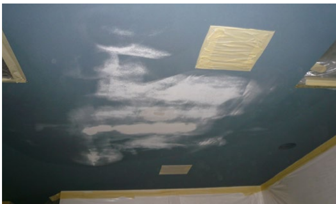
3. Шлифовка высохших стыков и распыление состава по поверхности.
